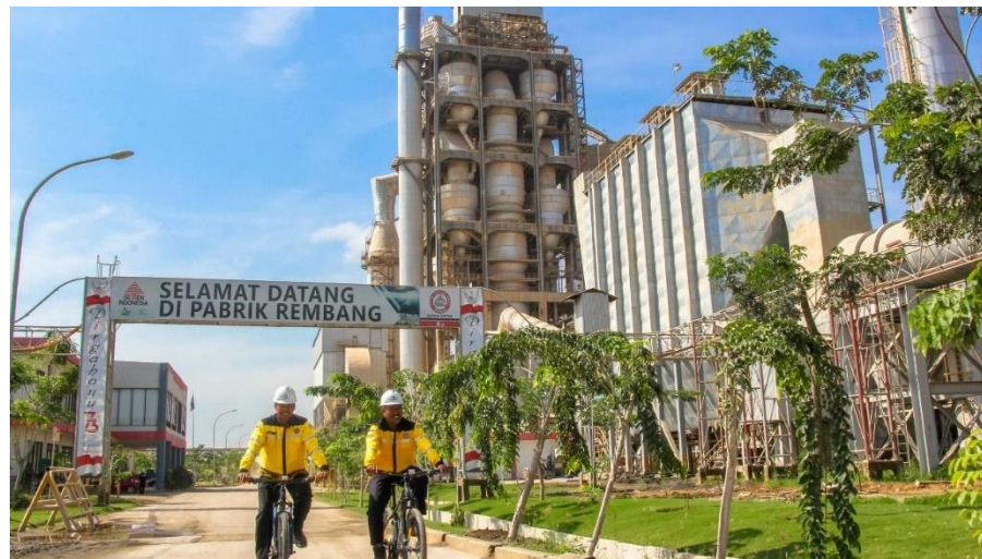
Gambar 2.2 Area pabrik PT Semen Gresik Pabrik Rembang (jatengprov.go.id, 2019)
